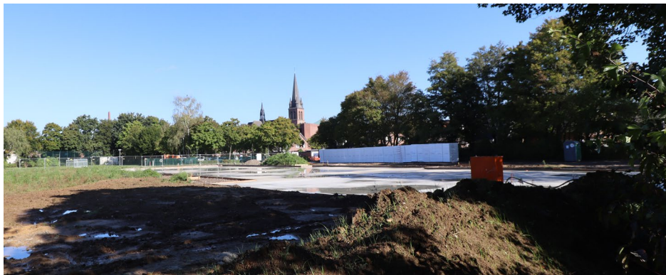
Die Bodenplatte des neuen DRK-Kindergartens an der Grundschule Oedt ist bereits gegossen. Hier sollen zudem neue Stellplätze entstehen.
