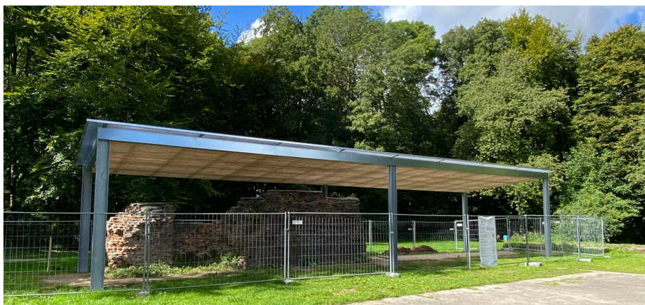
Ein Projekt des Heimatvereins Oedt: Das Schutzdach an der Burg Uda wurde vom Land NRW finanziell gefördert.
