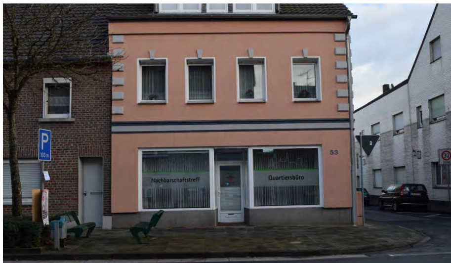
Abbildung 19 Quartiersbüro des Ev. Altenzentrums auf der Hochstraße
