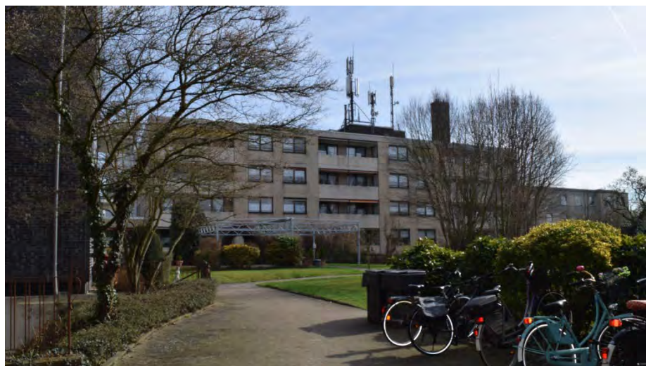
Abbildung 40 Innenhof Evangelisches Altenzentrum
