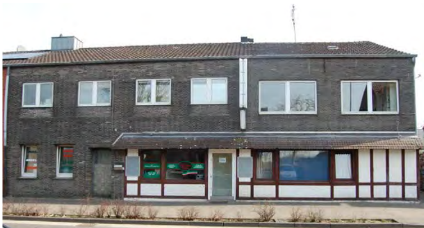
Abbildung 111 Beispiel Fassade mit gestalterischem Handlungsbedarf
